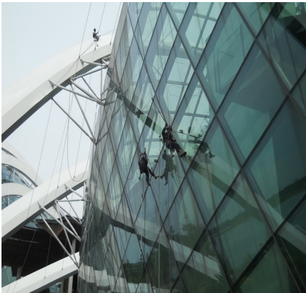
4. Slika: Primjer - staklena fasada pod nagibom [10]
