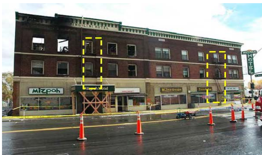
Slika 14: Prednje požarne stepenice [23].
