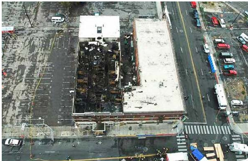
Slika 15: Razmjeri štete od požara – sjeverno krilo [23].
