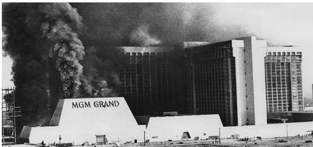
Slika 5: Dim koji izlazi iz ventilacija iznad krova Ziegfried dvorane [4].
