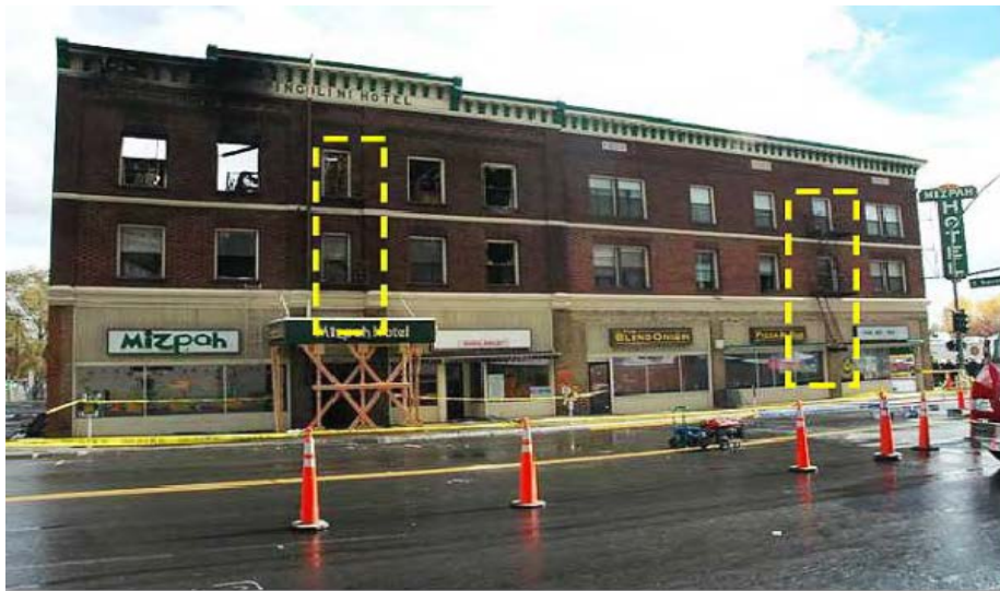
Slika 14: Prednje požarne stepenice [23].
