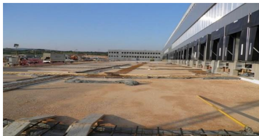
Slika 2 Distributivni centar Zagreb (gradnja skladišta)
