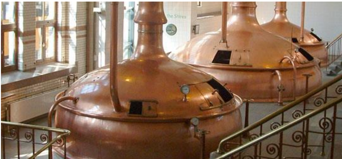
Slika 6. Kotlovi za kuhanje sladovine
