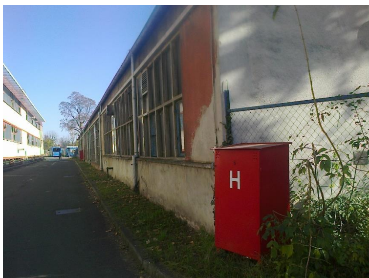
Slika 18. Prolaz na sjevernoj strani glavnog objekta
