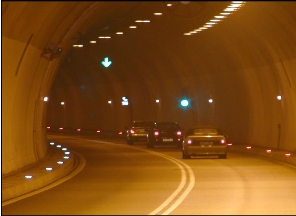
Sl. 12. Rasvjeta u Tunelu Mala Kapela [6]
