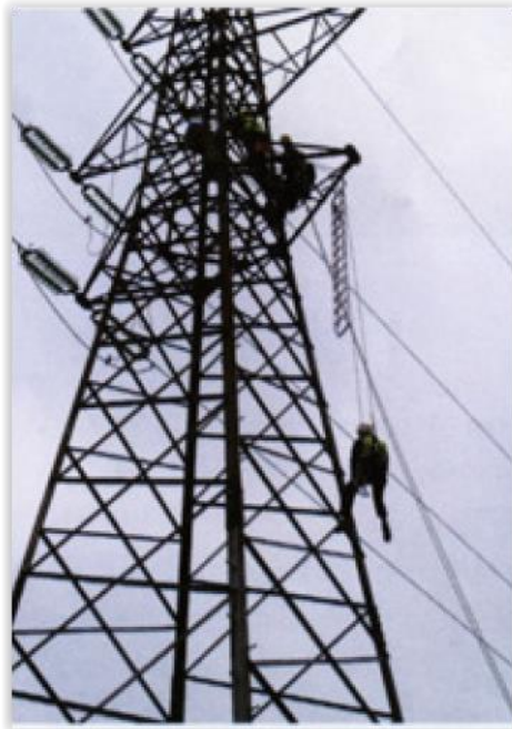
Slika 14. Spuštanje sigurnosnim užetom
