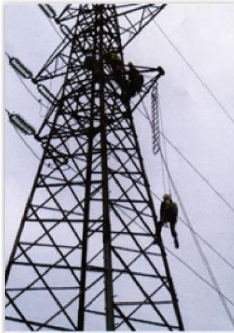
Slika 14. Spuštanje sigurnosnim užetom
