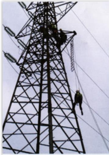
Slika 14. Spuštanje sigurnosnim užetom
