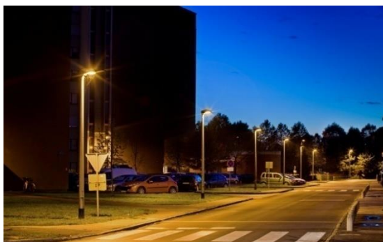
Sl. 18. Javna rasvjeta za cestovni promet[3]
