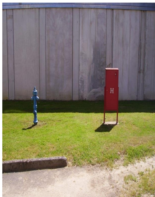
Slika 19. Vanjski hidrantski ormarić [izrada autora]
