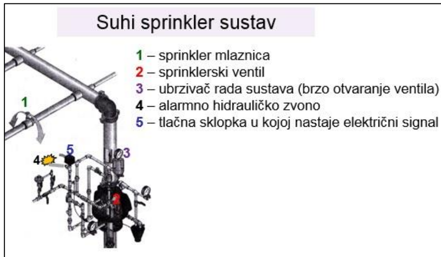
Sl. 4. Suhi sprinkler sustav i njegovi dijelovi [8]
