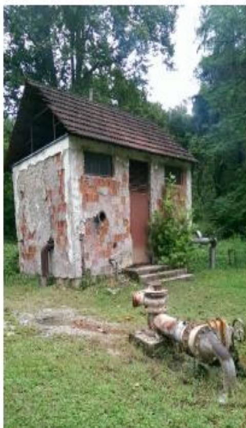
Slika 18. TEB-2 (ne proizvodi), potrebna sanacija ili adekvatno hermetičko zatvaranje bušotine.
