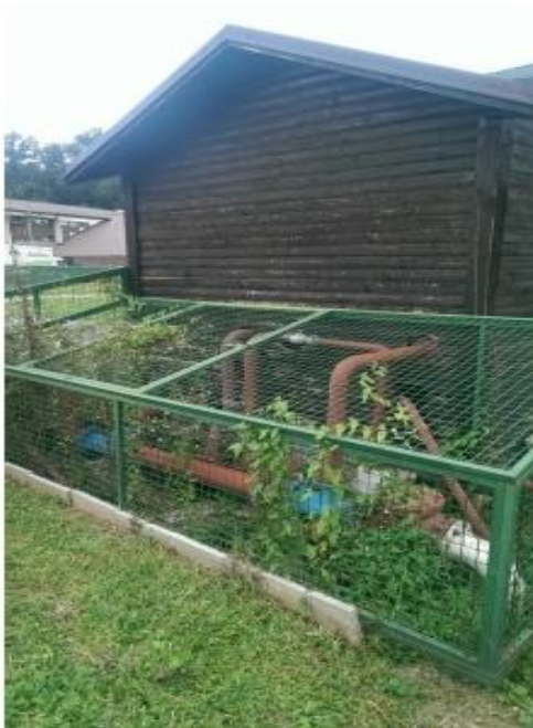
Slika 17. Izlaz bušotine TEB-1 iz zemlje.
