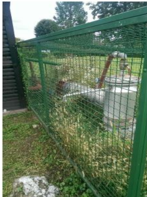
Slika 17. Izlaz bušotine TEB-1 iz zemlje.
