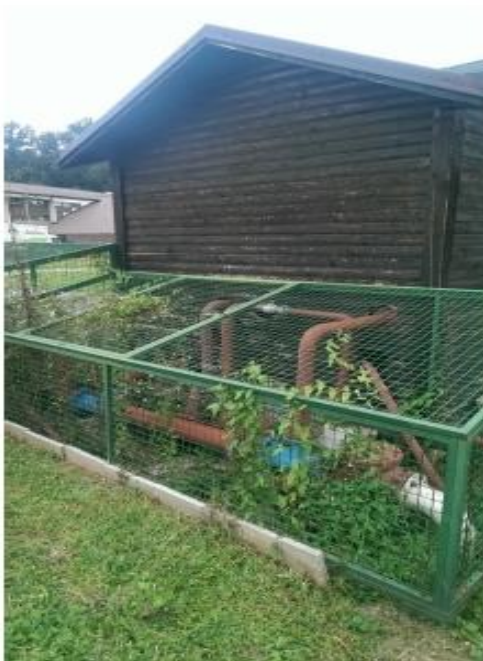
Slika 17. Izlaz bušotine TEB-1 iz zemlje.
