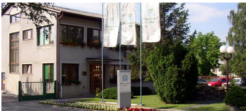
Slika 1. Zagorski vodovod d.o.o.
