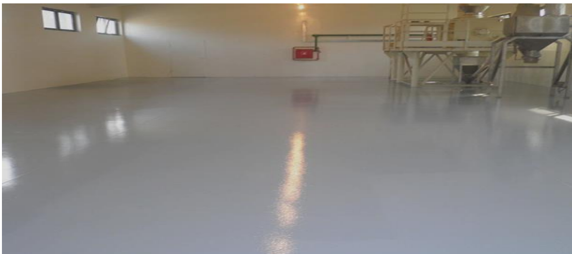
Slika 1. Podna obloga sa epoksidnim premazom.
