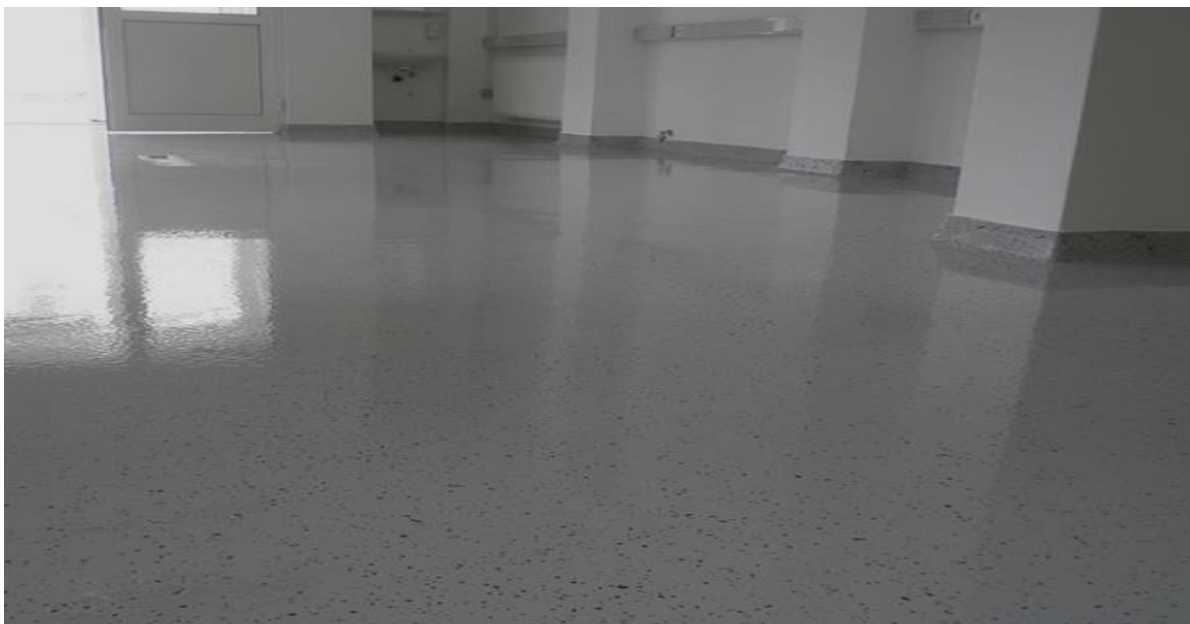
Slika 4. Lijevani pod sa posipom (samoliv).
