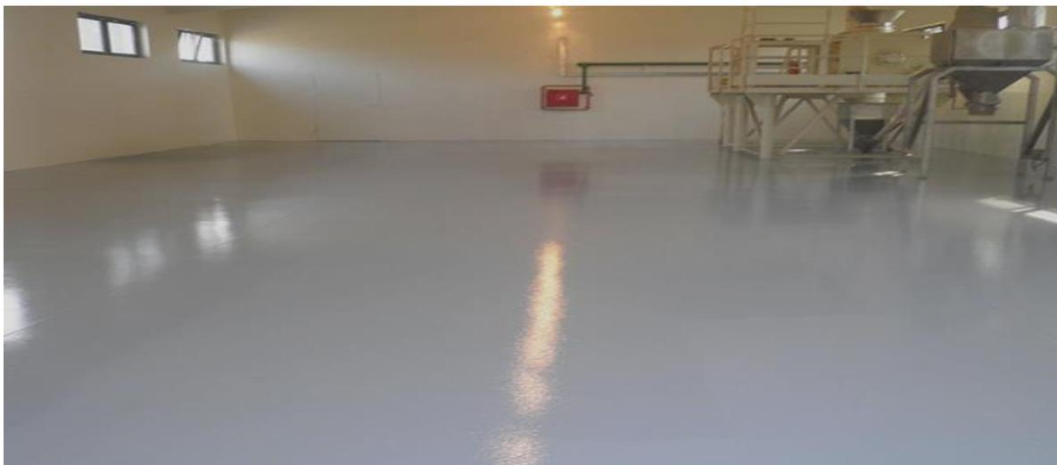
Slika 1. Podna obloga sa epoksidnim premazom.
