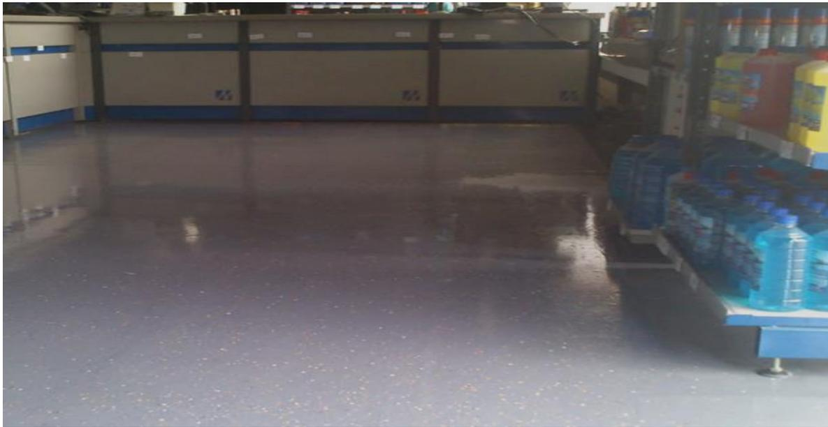
Slika 2. Podna obloga sa epoksidnim premazom i posipom.
