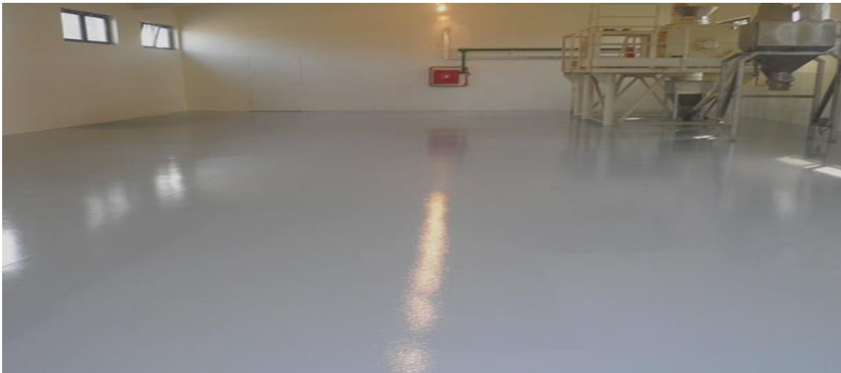
Slika 1. Podna obloga sa epoksidnim premazom.
