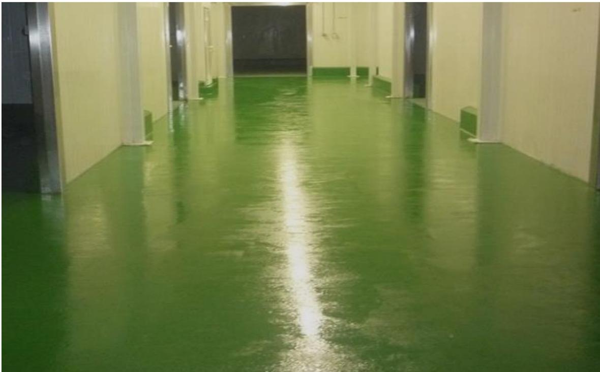
Slika 5. Epoksidni premaz zasićen kvarcnim pijeskom.
