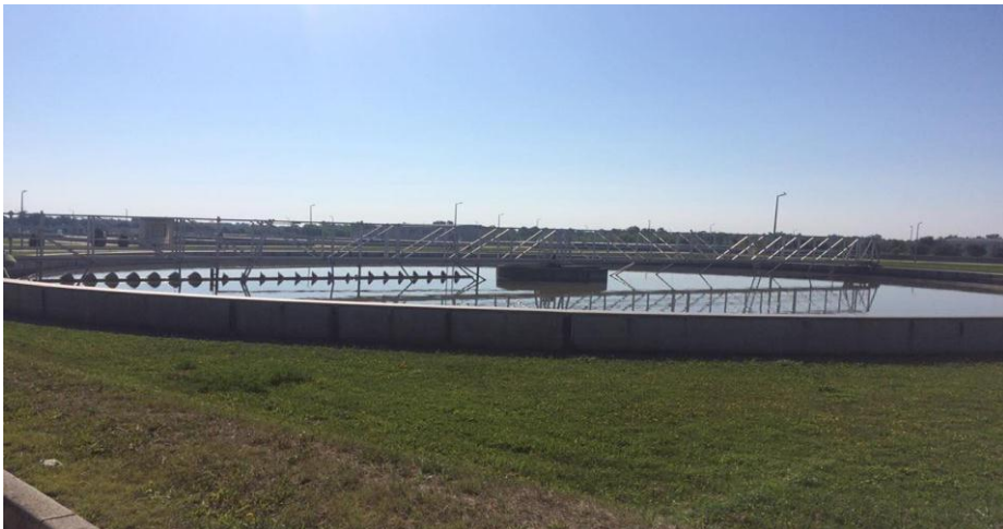
Slika 4: Naknadni taložnik (Izvor: fotografija, Marija Dokozić)
