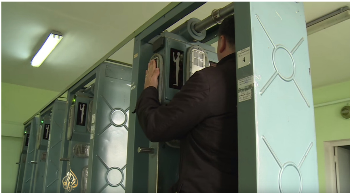
Slika 10. Stroj za utvrđivanje razine radijacije u ljudskom tijelu
