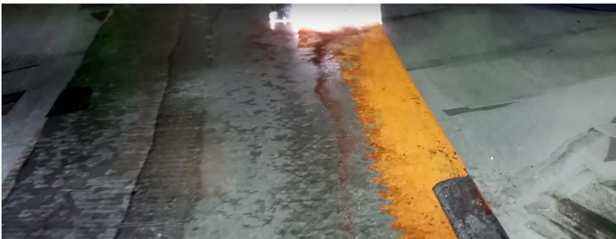
Slika 26. Prikaz površine nakon laserske obrade skidanja korozije
