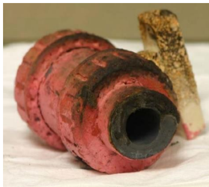
Slika 30: Dio otkinute PVC cijevi koja je spajala regulator razine s prirubnicama spremnika [20].
