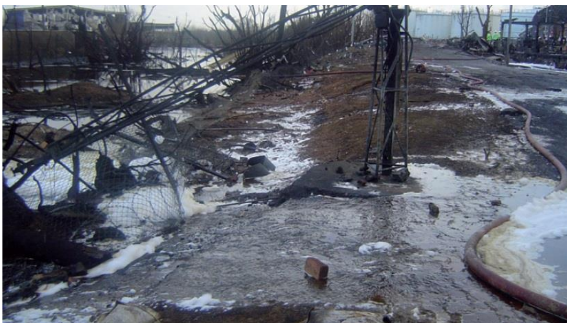
Slika 26: Mješavina goriva, vode i vatrogasne pjene koja je otekla izvan sabirnih prostora naftnog terminala [6].
