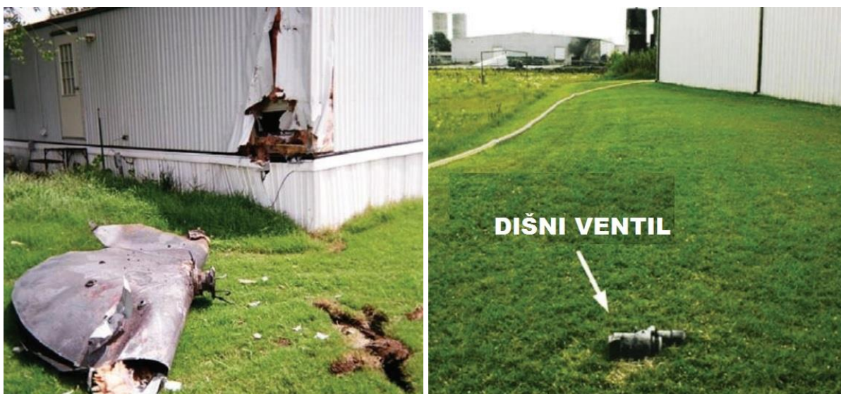
Slika 37 (lijevo): Mjesto zabijanja dijela oplata spremnika u mobilnu kuću [19].
