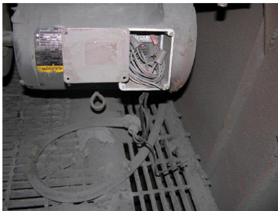
Slika 14. Motor i izložene žice [14].
