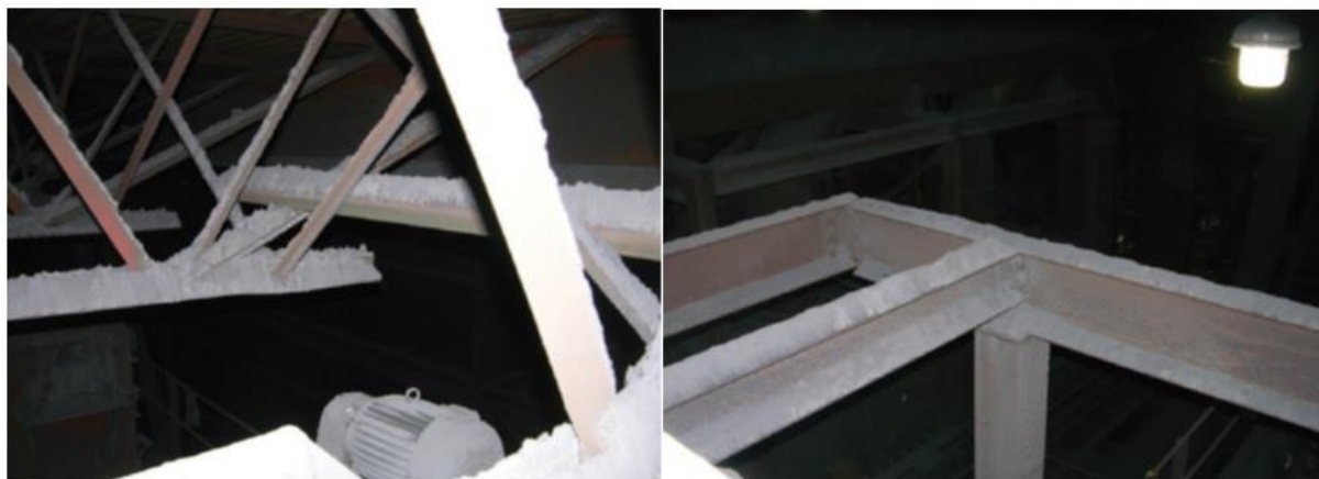
Slika 15. Nakupine praškaste gorive tvari [14].
