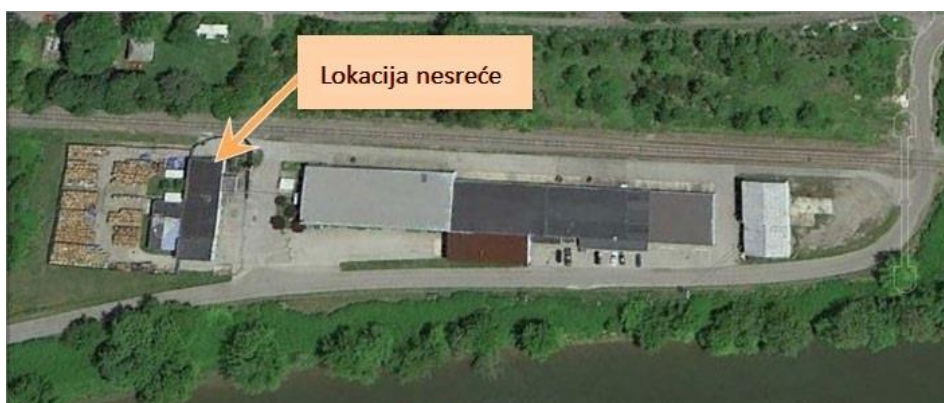
Slika 1. Pogled na postrojenje prije nesreće [11].
