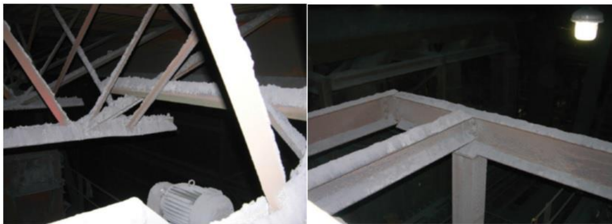
Slika 15. Nakupine praškaste gorive tvari [14].
