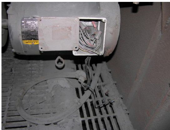
Slika 14. Motor i izložene žice [14].
