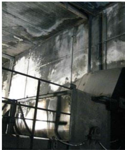
Slika 6. Miješalica i okolni zid i strop [11].
