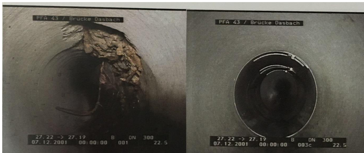
SI. 3. Postupak popravka: Sustavi naglavka [4]
