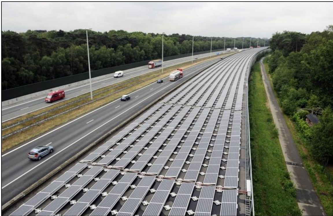
Slika 4.2.: Solarne ćelije iznad tunela [38]
