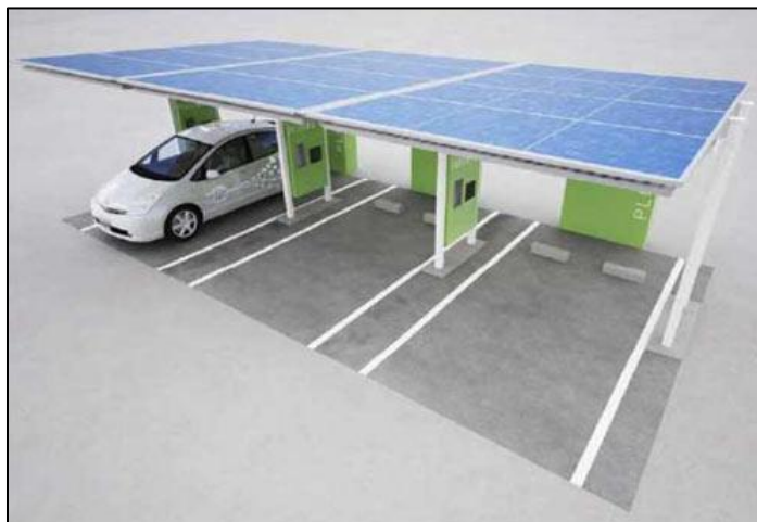
Slika 3.3.3.: Izvedba punionice kao solarne nadstrešnice
