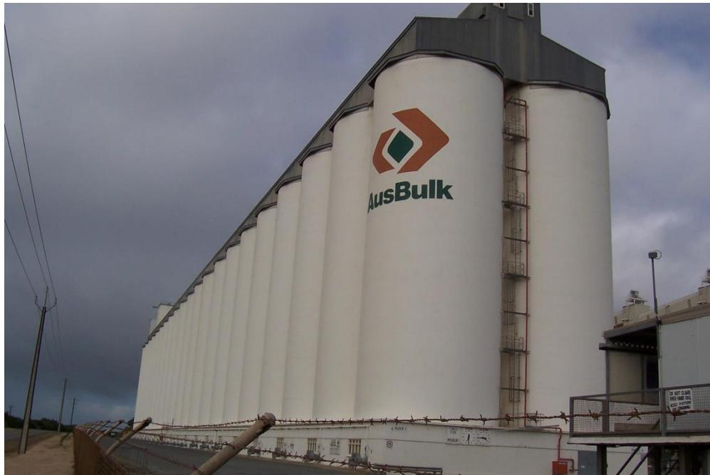
Sl.7. Betonski silos sa 42 komore silosa [8]
