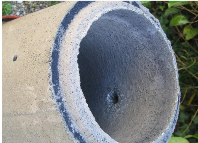
Sl.28. Primjer probijanja betona sustavom "Cobra" [20]
