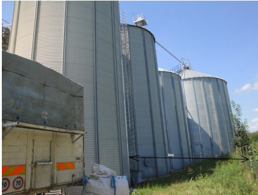
Sl.22. Prostor između komore silosa i ograde [14]
