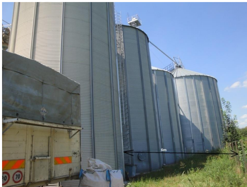
Sl.22. Prostor između komore silosa i ograde [14]
