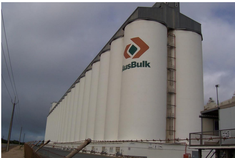
Sl.7. Betonski silos sa 42 komore silosa [8]
