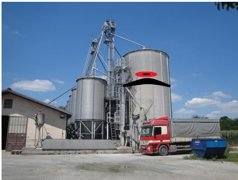
Sl.23. Most krutine ispod žarišta požara [14]
