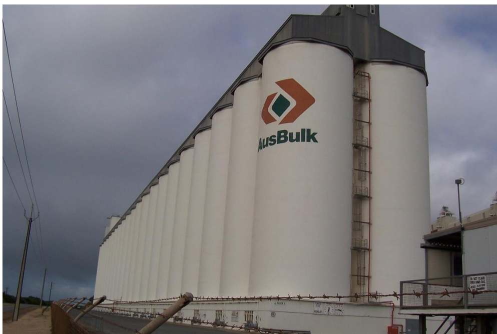
Sl.7. Betonski silos sa 42 komore silosa [8]
