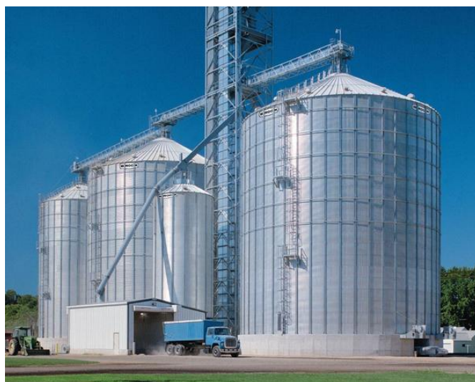
Sl.6. Čelični silos sa 4 komore silosa [7]
