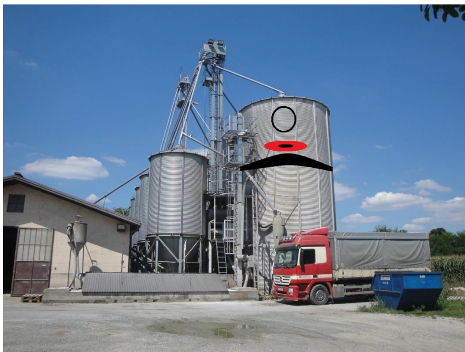
Sl.24. Položaj otvora za ispust opožarene pšenice [14]
