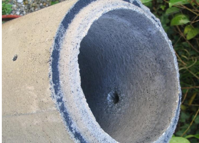
Sl.28. Primjer probijanja betona sustavom "Cobra" [20]
