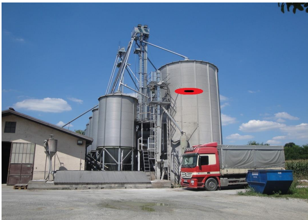
Sl.21. Položaj žarišta požara u komori silosa [14]
