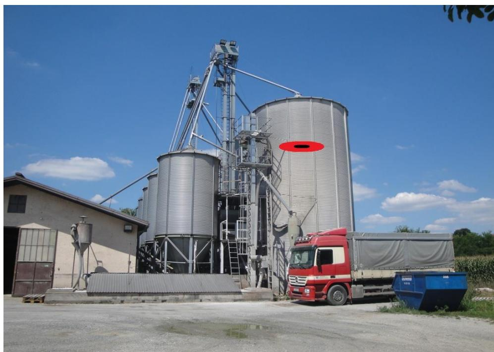
Sl.21. Položaj žarišta požara u komori silosa [14]
