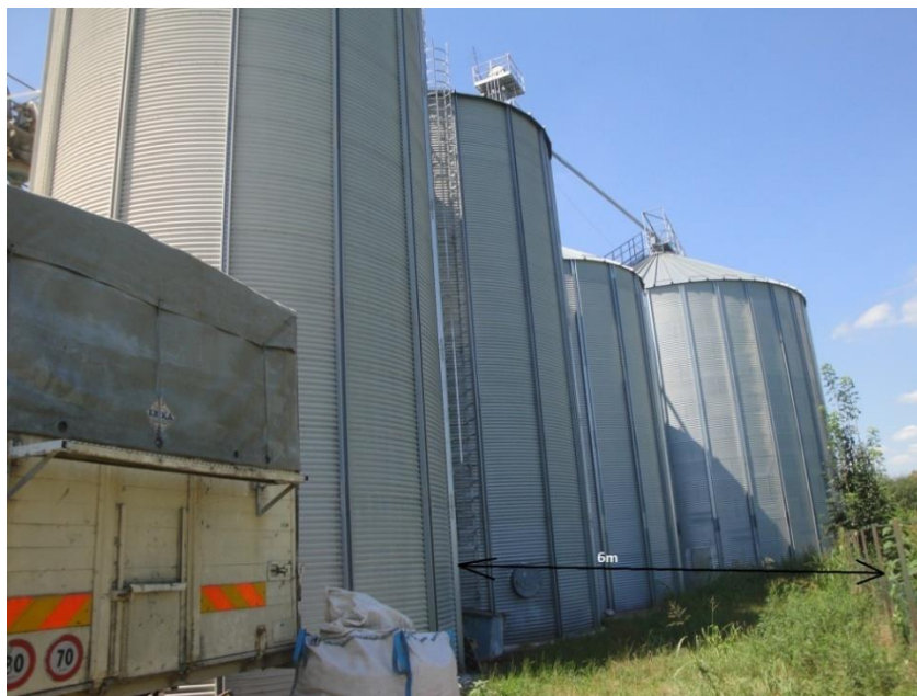
Sl.22. Prostor između komore silosa i ograde [14]
