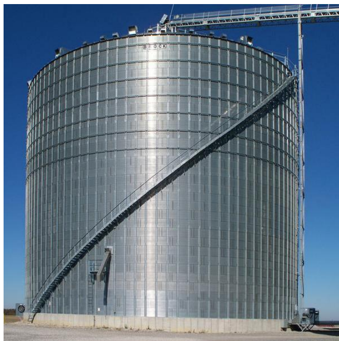
Sl.5. Čelični silos [6]
