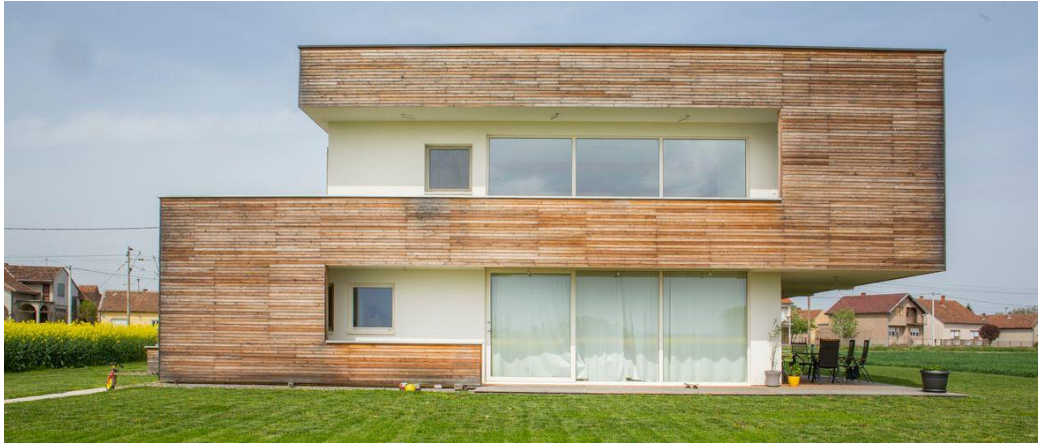
Sl. 2. Prva moderna kuća od slame, Vinkovci [1]
