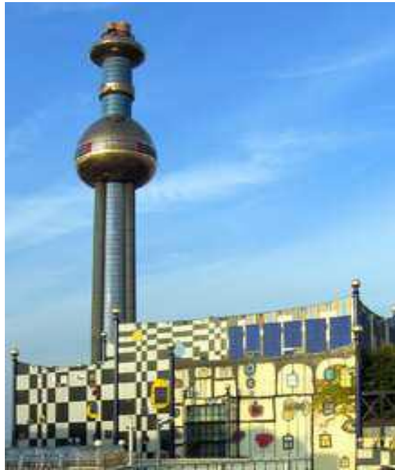
Slika 6. Spalionica otpada Spittelau (Beč, Austrija) [9]
