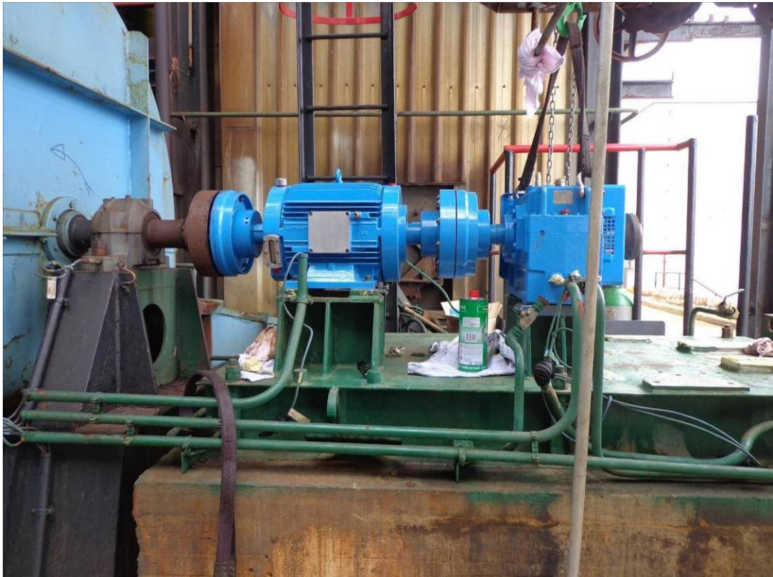
Fotografija 6.1 Montaža reduktora i uključno-isključne spojke
