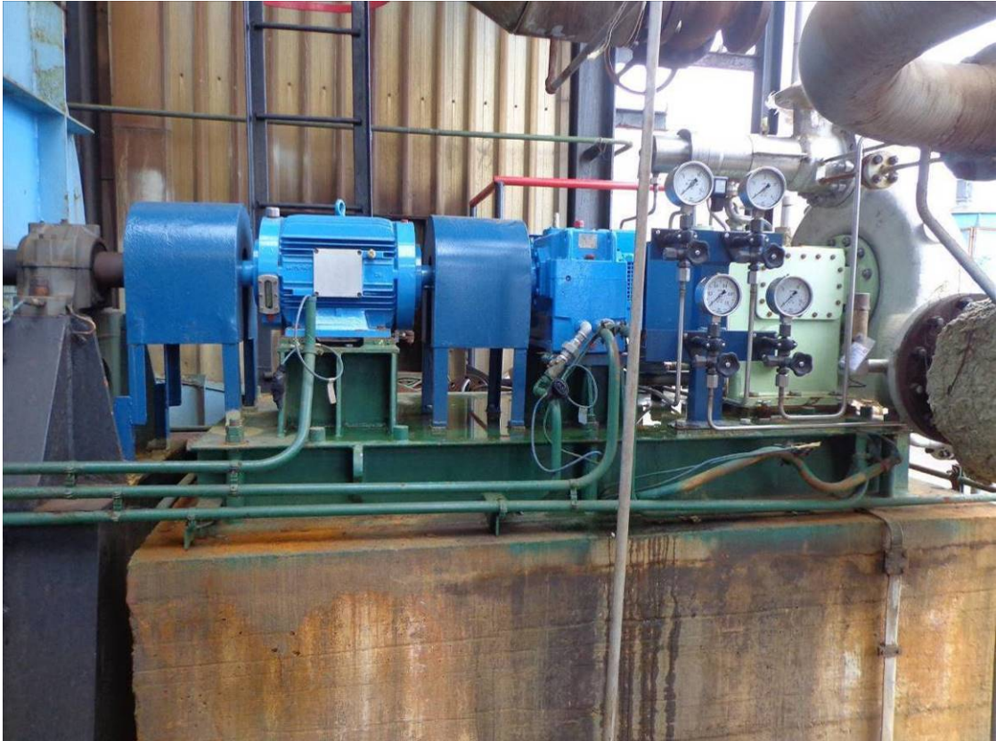
Fotografija 6.5 Montaža lokalne instrumentacije
