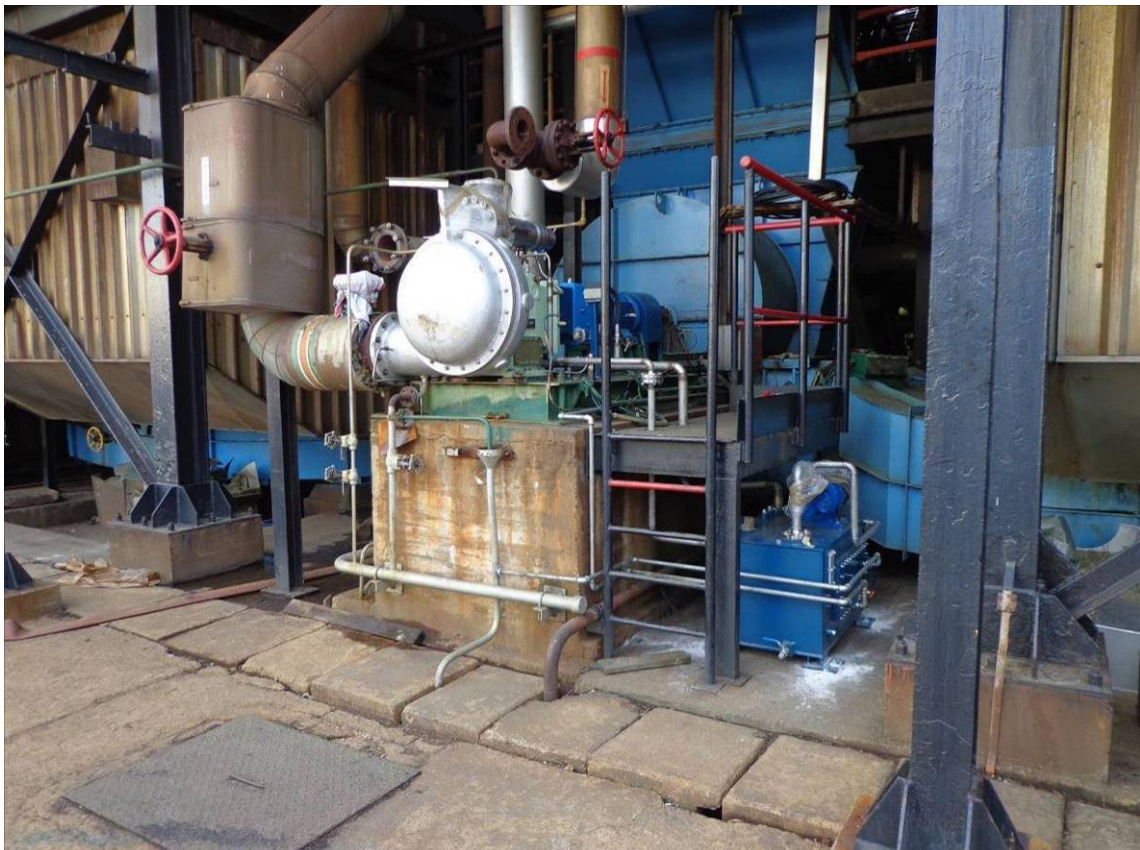
Fotografija 6.4 Montaža cjevovoda i uljnog spremnika
