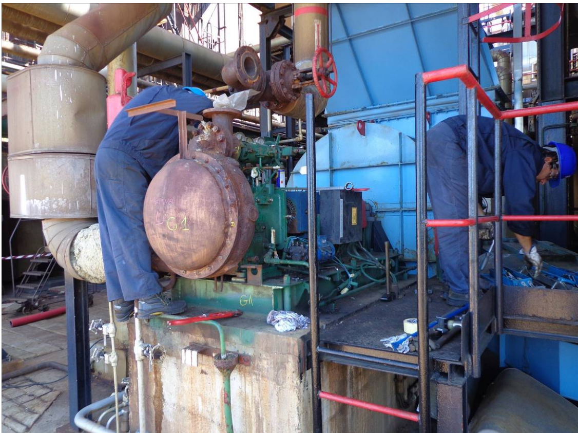
Fotografija 3.4 Demontaža turboagregata
