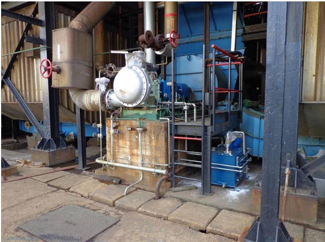
Fotografija 6.4 Montaža cjevovoda i uljnog spremnika
