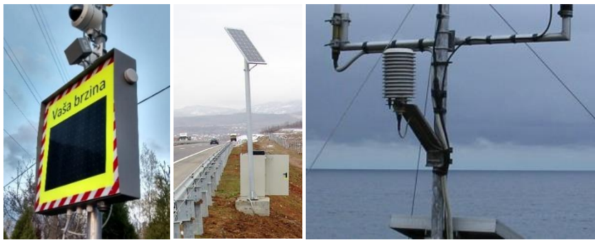
Slika 8 Mjerač brzine vozila, induktivno brojilo prometa, cestovna meteo postaja
