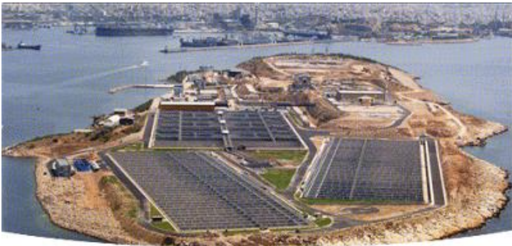
Slika 41: Postrojenje za obradu otpadnih voda
