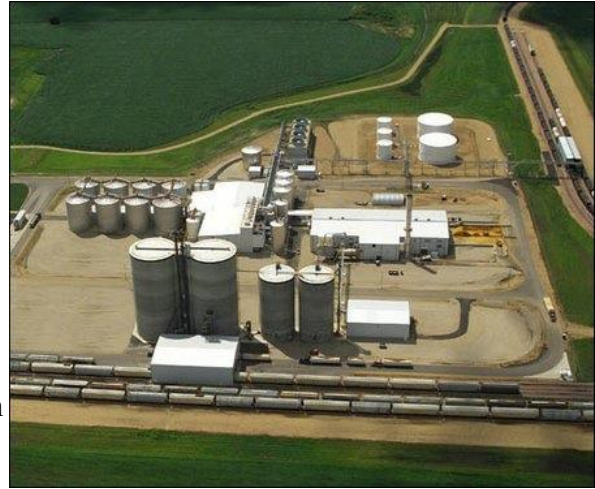
Slika 22: Postrojenje za biodizel kapaciteta 80000t/god
