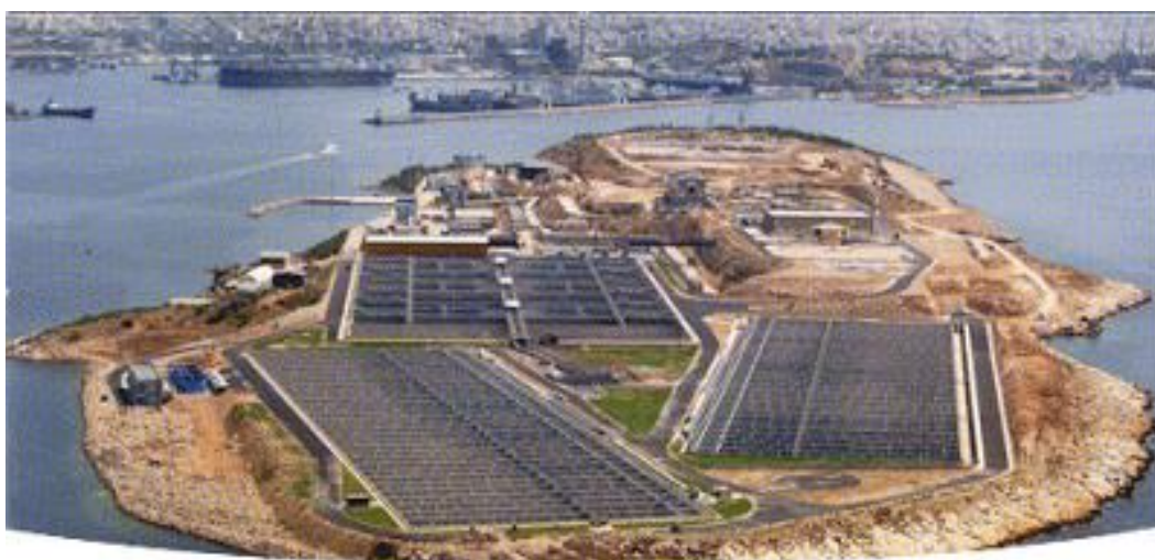
Slika 41: Postrojenje za obradu otpadnih voda
