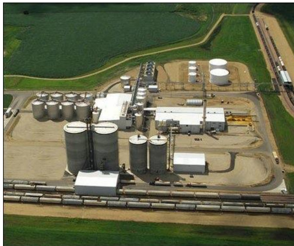
Slika 22: Postrojenje za biodizel kapaciteta 80000t/god
