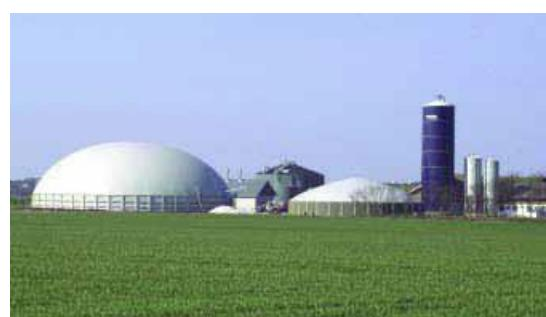
Slika 39: Postrojenje za proizvodnju bioplina na farmi, kodigestija stajskog gnoja i energetskih usjeva
