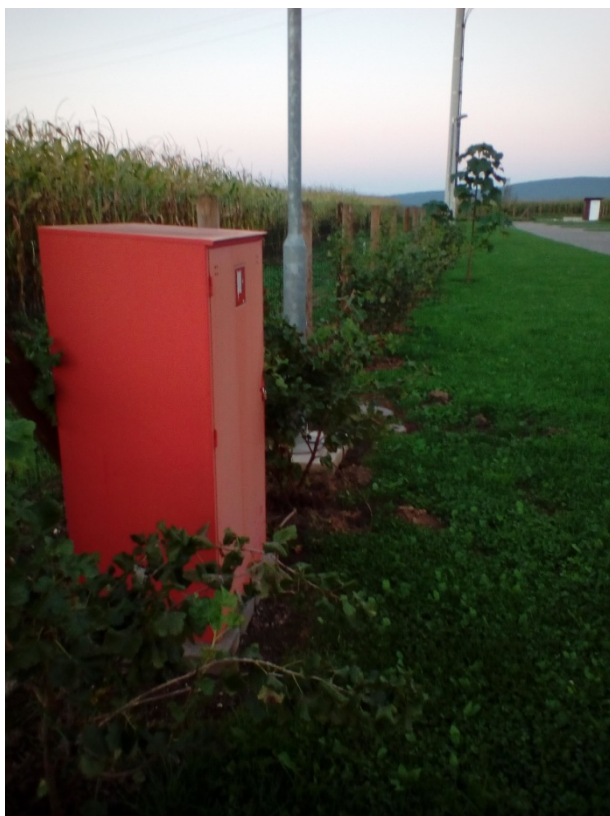
Slika 25. Vanjski hidrant u kamp odmorištu [14]
