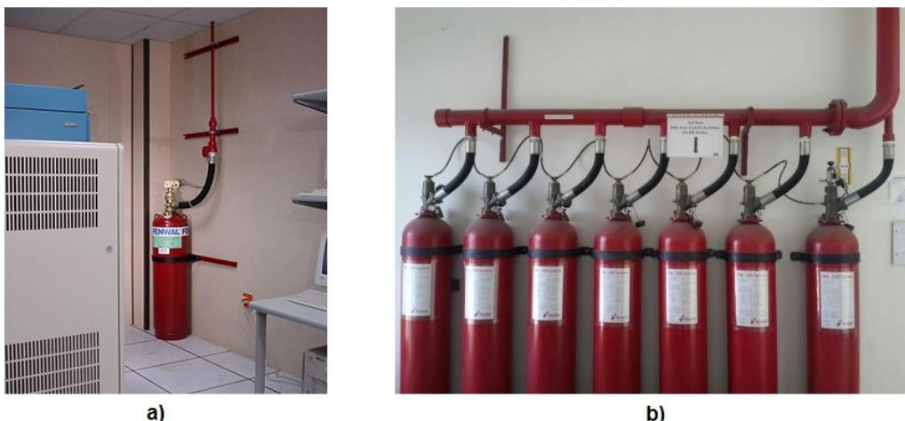
Sl. 26. Primjer spremnika plina FM-200: a) pojedinačni, b) baterija boca
