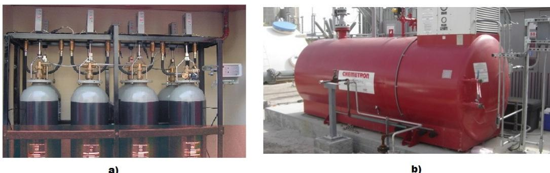
Sl. 19. Primjer spremnika plina u sustavima za gašenje s CO<sub>2</sub>:
