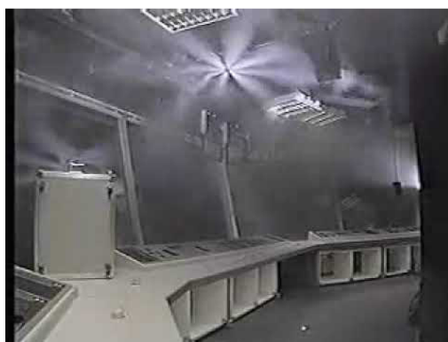
Sl. 30. Primjer raspršivanja plina FM-200 s mlaznicom
