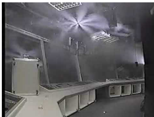
Sl. 30. Primjer raspršivanja plina FM-200 s mlaznicom
