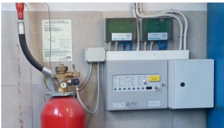
Sl. 42. Prikaz smještaja centrale za gašenje plinom FM-200
