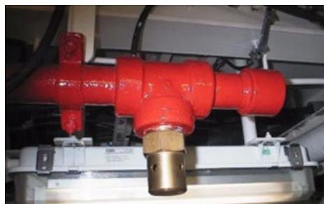
Sl. 20. Primjer mlaznice sustava za gašenje požara halonom
