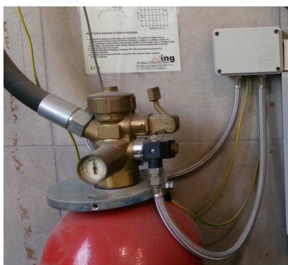
Sl. 39. Prikaz ventila na spremniku plina FM-200
