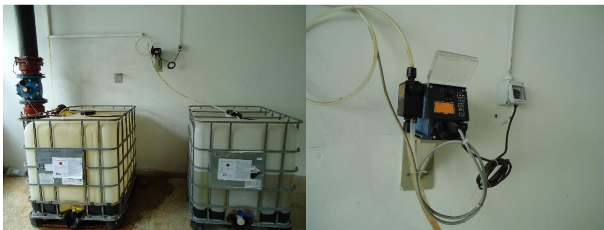
Slika 5. - Aluminijev poliklorid i uređaj za doziranje
