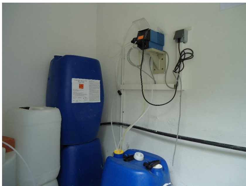
Slika 4. - Natrijev hipoklorid i uređaj za doziranje
