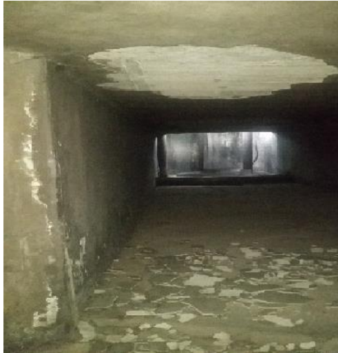
Slika 14. Prikaz usisnog kanala
