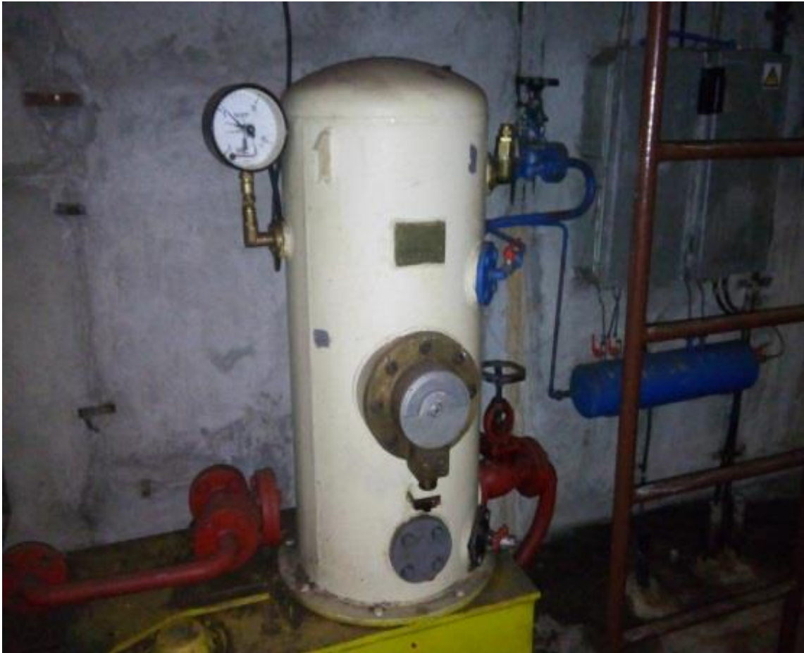
Slika 17. Spremnik za kočenje generatora
