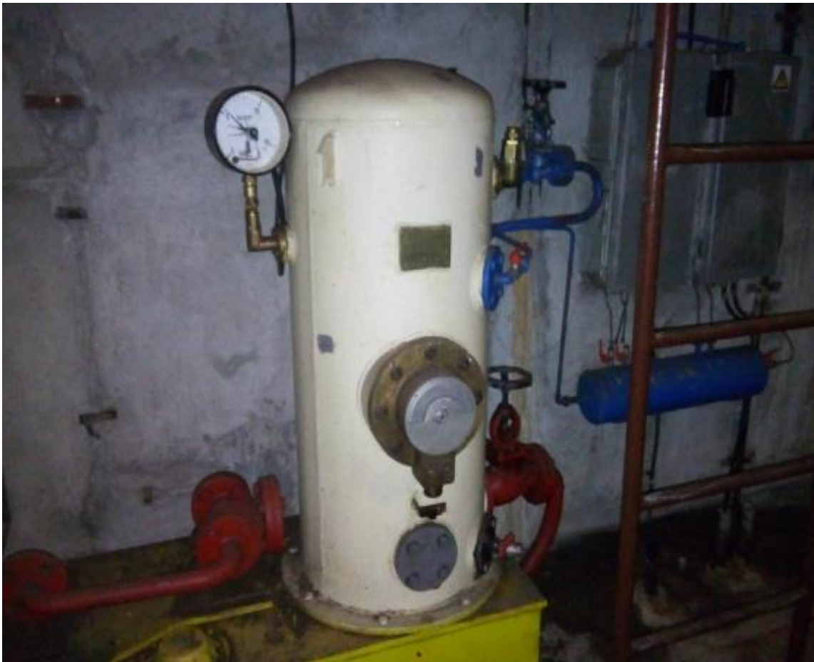
Slika 17. Spremnik za kočenje generatora
