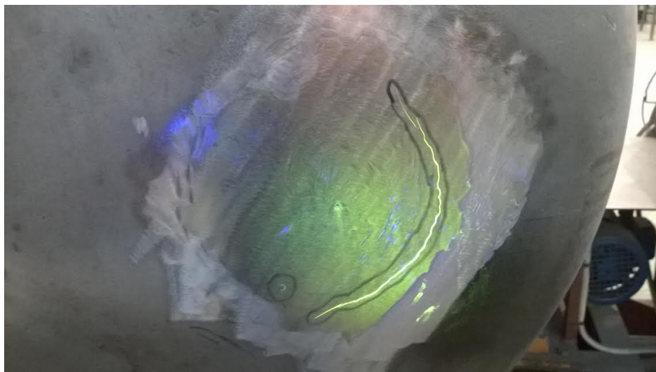
Slika 15. Indikacija pukotine primjenom magnetskih čestica [11]
