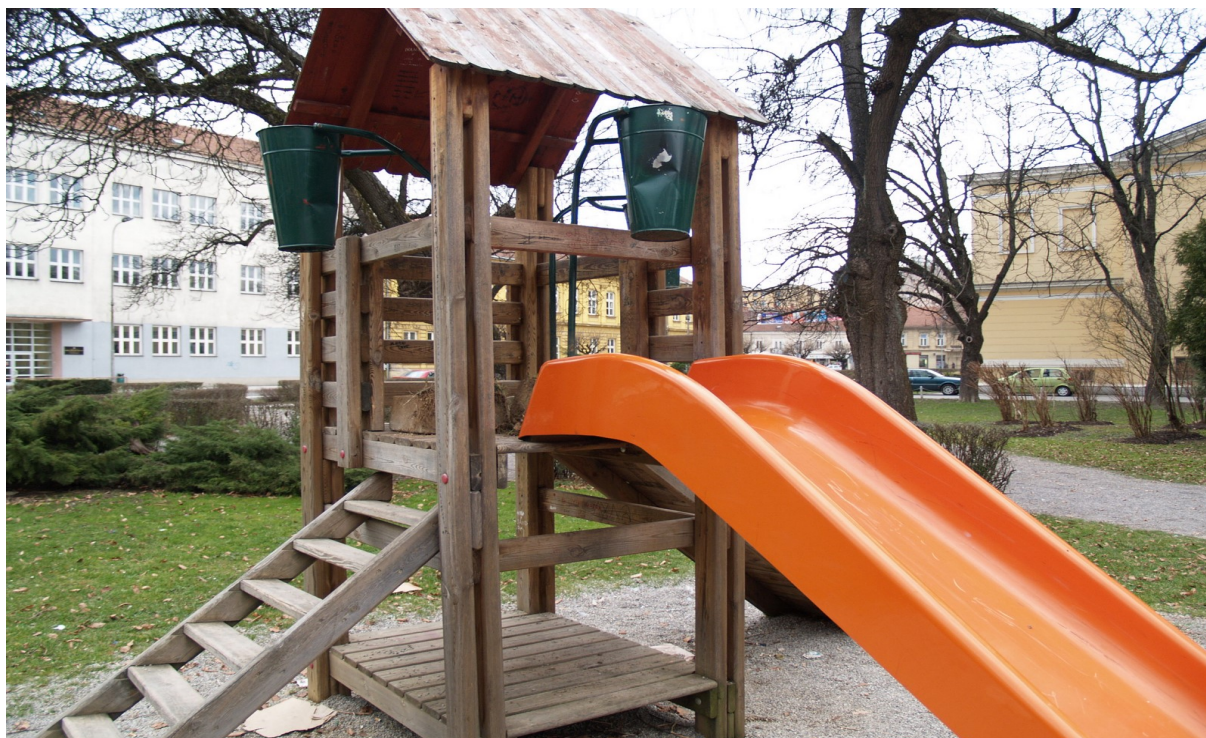
Slika br.26.: Uništavanje kanti za otpad i dječjih sprava za igranje 42
