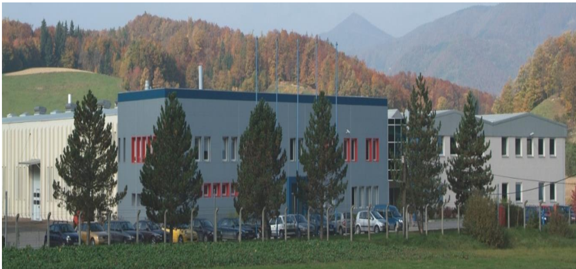
Slika 2. Upravna zgrada i dio pogona OMCO Croatia d.o.o.
