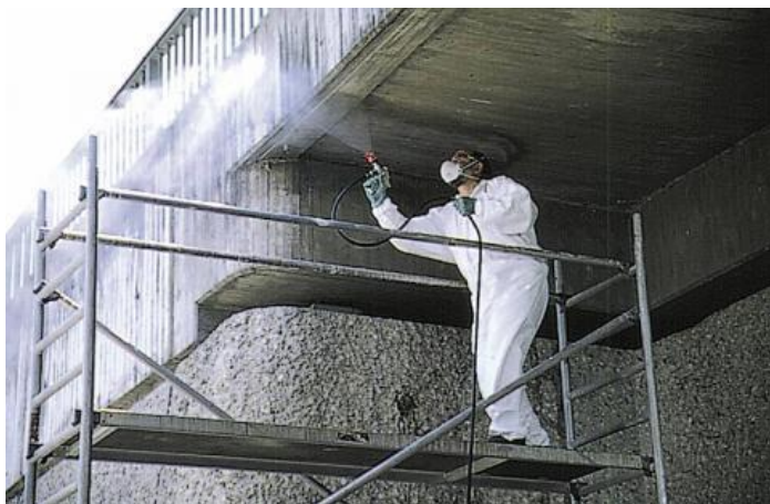
Slika 7. Prikaz pravilnog korištenja osobne zaštitne opreme prilikom žbukanja [http://sogradi.hr/wp-content/uploads/2016/02/Analiza-stanja-za%C5%A1tite-na-radu-u-sektoru-gra%C4%91evinarstva.pdf]
