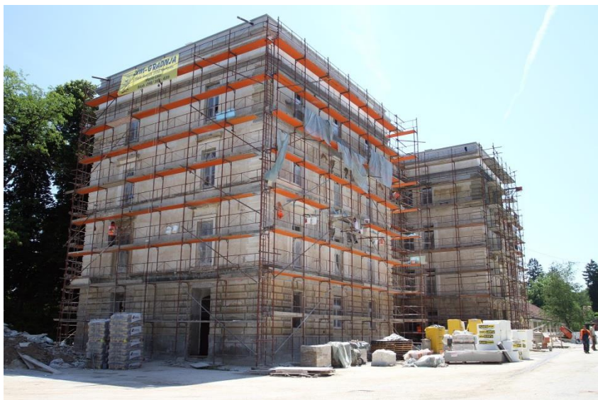
Slika 8 Prikaz postavljenih skela na gradilištu
