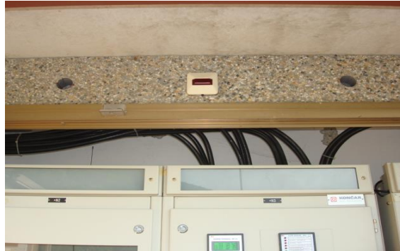
Slika 10 - Indikator prorade javljača iznad vrata trafostanice [4]
