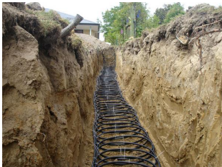
Slika 17. Spiralni kanalni kolektor u jarku [4]
