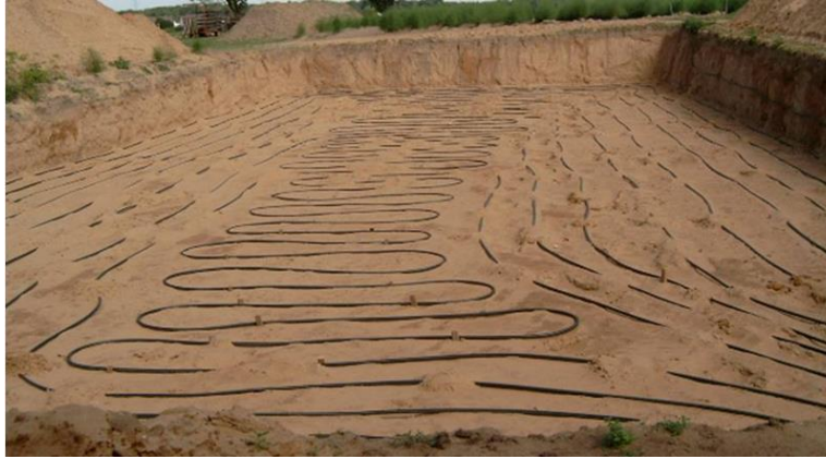
Slika 16. Vodorravno kolektorsko polje sa serijskim povezanim cijevima [4]
