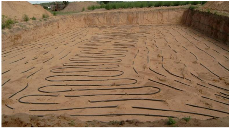
Slika 16. Vodorravno kolektorsko polje sa serijskim povezanim cijevima [4]
